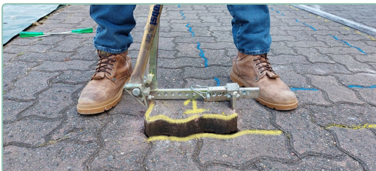
Figura 5. Retirada da primeira peça com uso de extrator.
