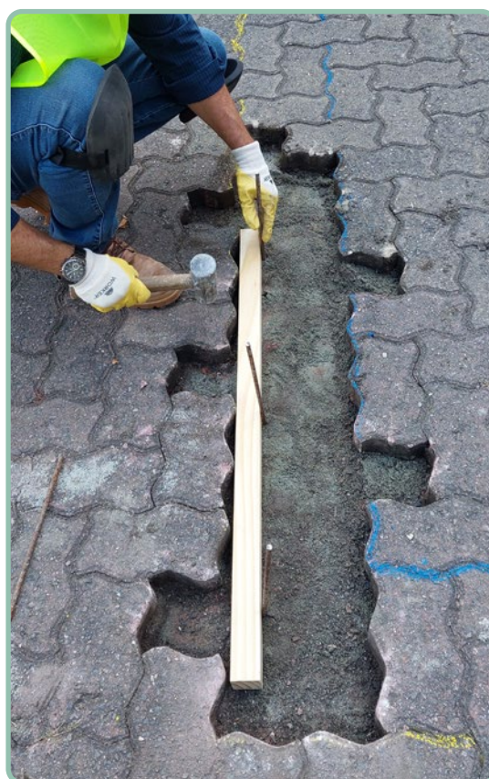
b) Início da colocação da contenção, antes da abertura total, evitando-se a movimentação das peças.
