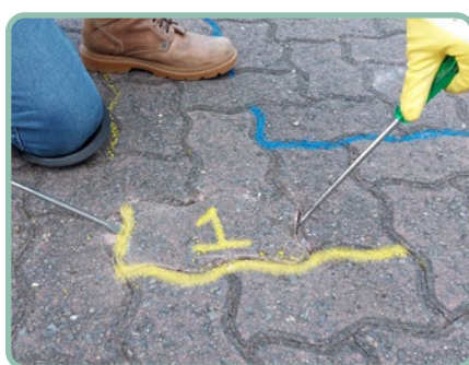
b) Levantar a peça de concreto utilizando-se duas chaves de fenda grandes.
