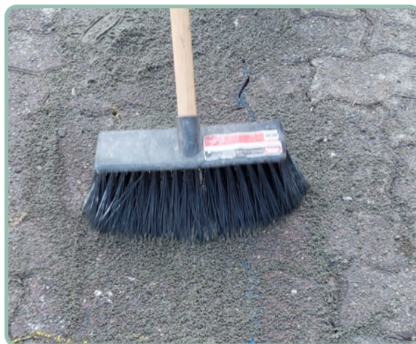
b) Aplicação do material de rejuntamento para posterior compactação.
