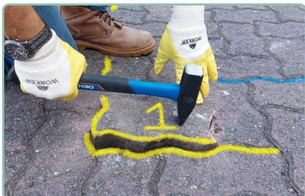
a) Peça de difícil remoção sendo quebrada com martelo picador.
