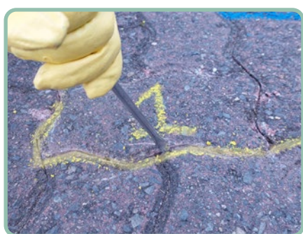
a) Remoção de areia de rejuntamento ao redor da primeira peça de concreto a ser removida.
