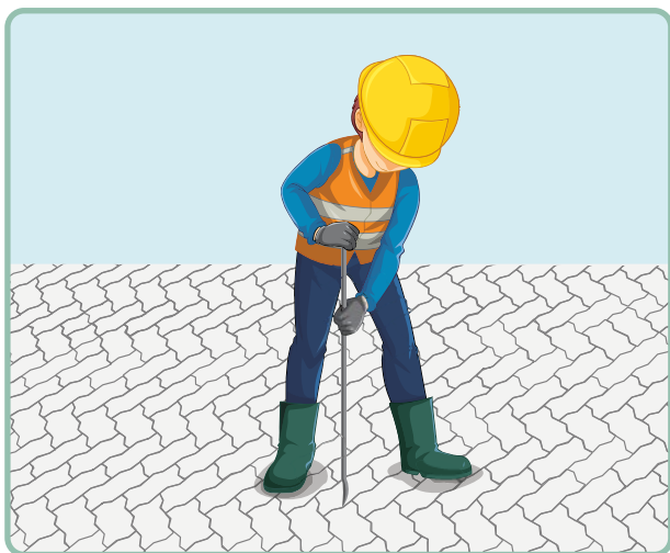
a) Uso da alavanca para alinhamento das peças antes do rejuntamento.
