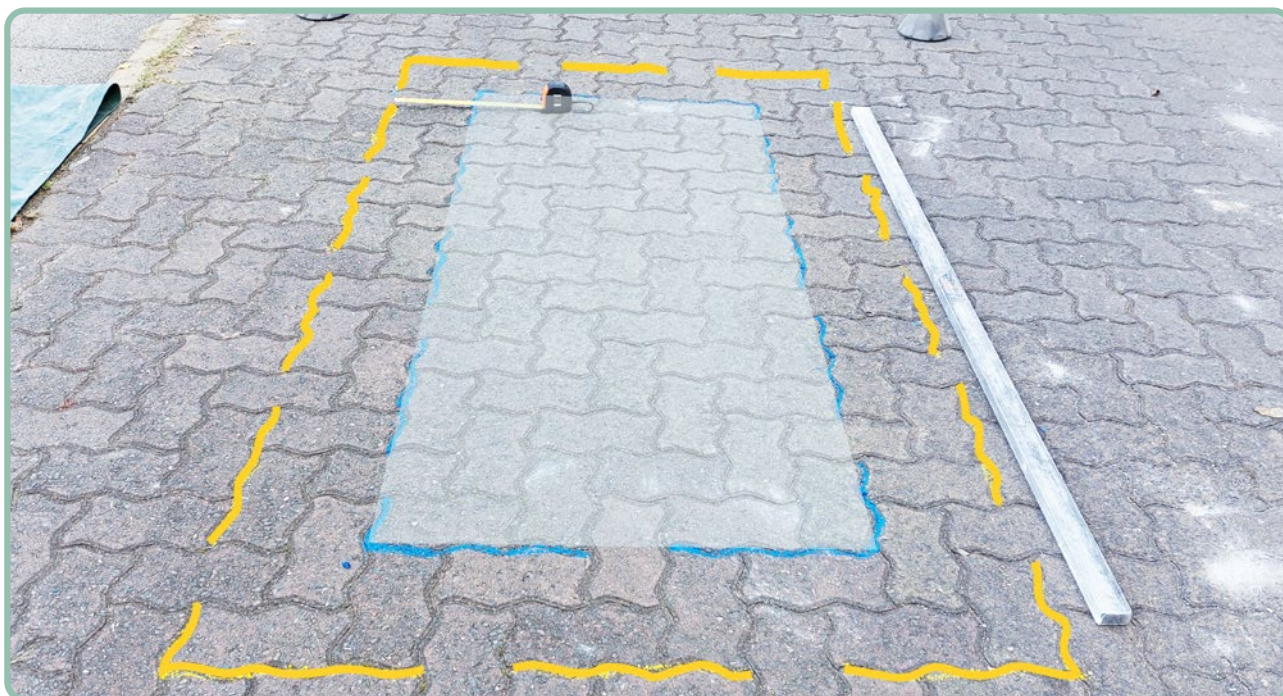
Figura 3. Demarcação da área de intervenção no pavimento.
