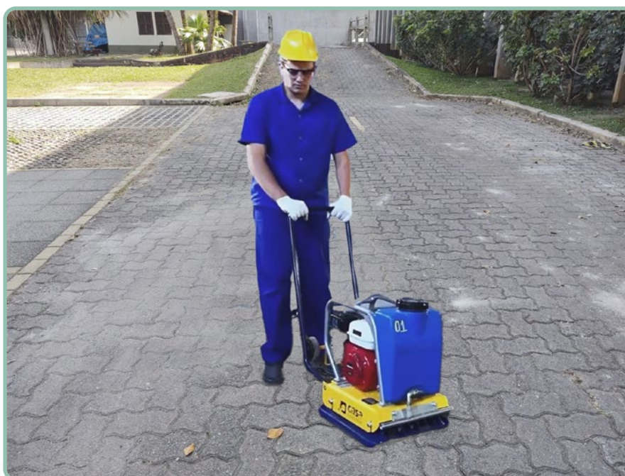
Figura 14. Compactação da área sob intervenção.
