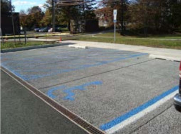
O revestimento de concreto permeável apresenta alta porosidade permitindo a infiltração de água. O concreto permeável é constituído de pasta cimentícia que envolve os agregados e possui baixo teor de finos, ou mesmo sem finos. Tipicamente apresenta de 15% a 25% de teor de vazios e atinge um coeficiente de permeabilidade por volta de 0,34 cm/s.
