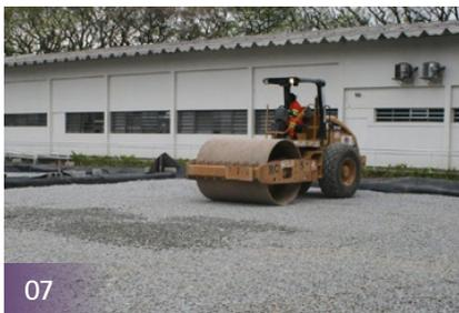
Compactação do subleito, espalhamento e compactação do solo de reforço e nivelamento (caso necessário);
