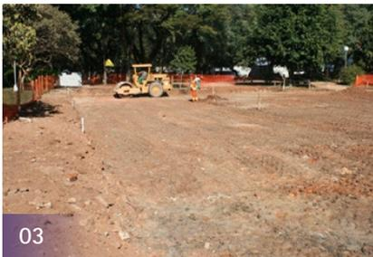
Compactação do subleito, espalhamento e compactação do solo de reforço e nivelamento (caso necessário);
