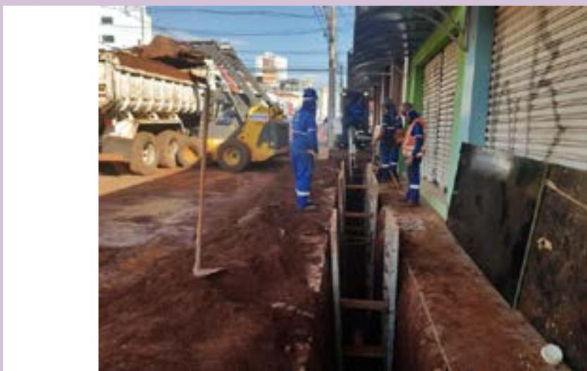
*Execução de escavações para implantação da nova rede de esgoto lindeiros à testada dos imóveis.*
