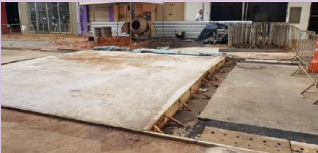
*Execução de travessia em nível para uso dos pedestres, elemento feito com concreto usinado armado e locado no meio de cada quadra no trecho requalificado.*
