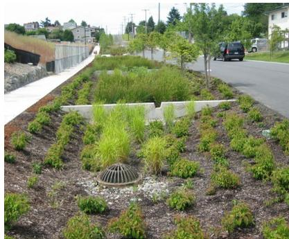
**Figura 123.** North Kellyville, Austrália. Vala de infiltração.
