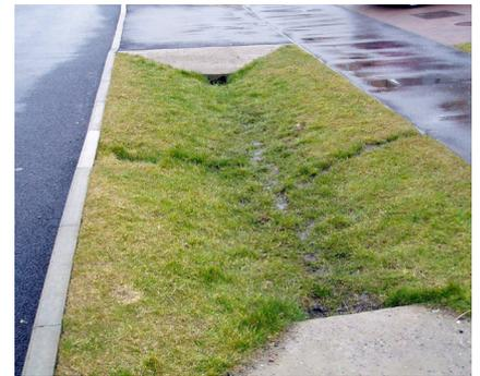
**Figura 124.** North Kellyville, Austrália. Vala de infiltração.
