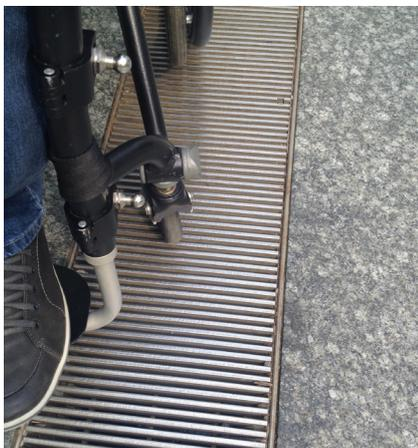
Figura 55. Grelha dos sonhos: instalada no sentido longitudinal ao passeio e seus vãos, além de transversais ao sentido do movimento, são muito estreitos e praticamente não causam trepidação. Além disso, o piso adjacente é regular, firme e estável, proporcionando uma circulação segura e confortável.
