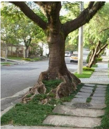
Figura 136. Flamboyant: Raízes superficiais acabam destruindo a calçada do entorno.
