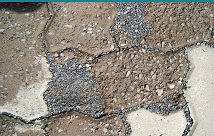
Foto 3 - Pavimento com desgaste por abrasão
