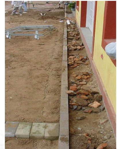
Alinhamento e nivelamento
