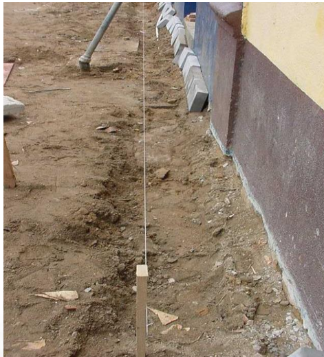
Controle do caimento e da espessura
