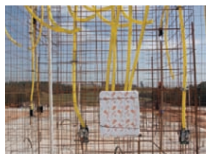
Armaduras, elétrica e hidráulica
