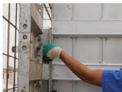
Colocação dos elementos de costura
