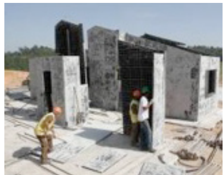
Montagem de fôrmas
