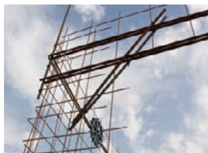
Armadura de reforço
