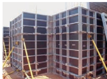
Fôrma Metálica + Compensado
