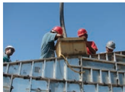
Lançamento de concreto com bomba
