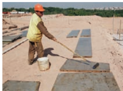
Limpeza e aplicação de desmoldante
