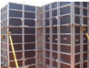
Fôrmas metálicas + Compensado
