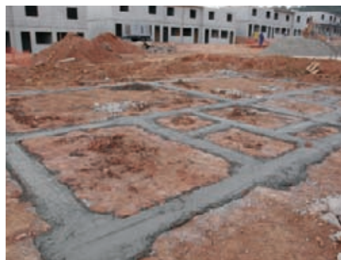
Fundação: sapata corrida
