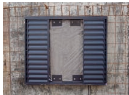
Detalhe de caixilho fixado à fôrma
