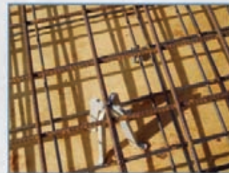
DISTANCIADORES PARA ARMADURAS NEGATIVAS
