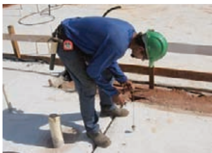
Marcação das paredes
