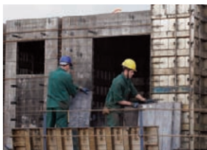
Montagem das fôrmas
