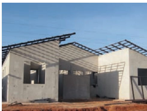
Parede de Concreto: estrutura e vedação
