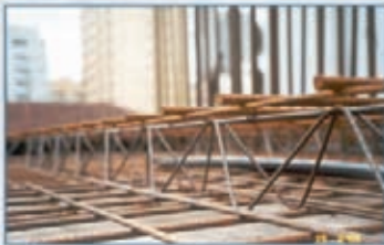
DISTANCIADORES PARA ARMADURAS NEGATIVAS
