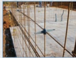
DISTANCIADORES PARA PAREDES
