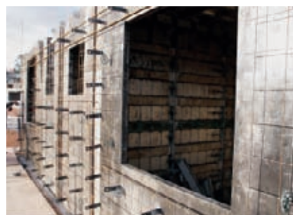
Montagem dos painéis internos primeiro e depois os externos
