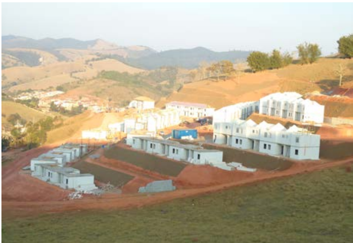
Implantação do Conjunto Habitacional durante as obras (Foto: Arquivo ABCP)
