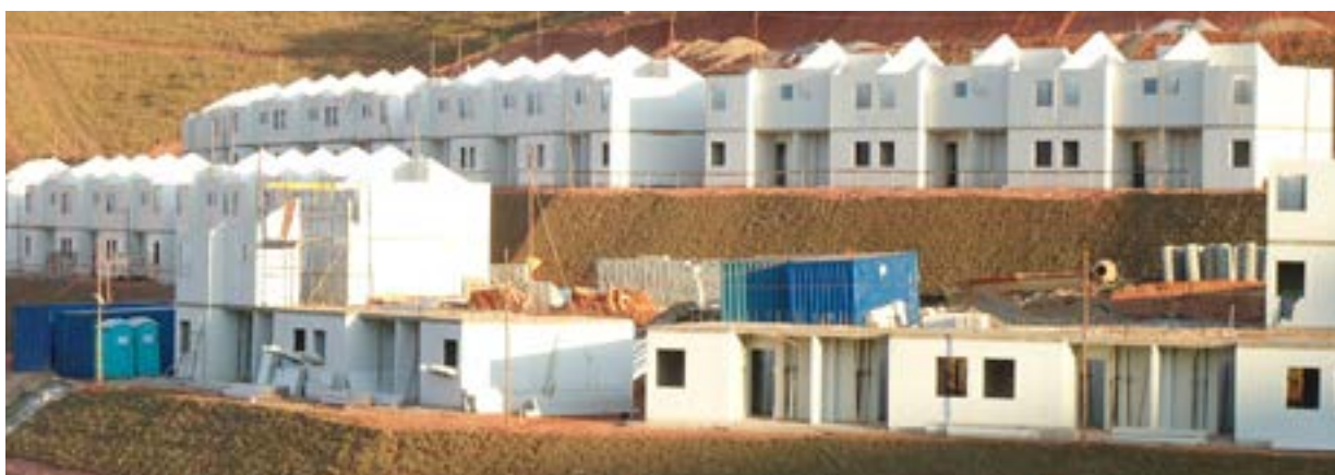
Casas térreas à frente e sobrados dispostos em renques de conjuntos de seis ou de quatro unidades. (Foto: Revista Infraestrutura Urbana)
