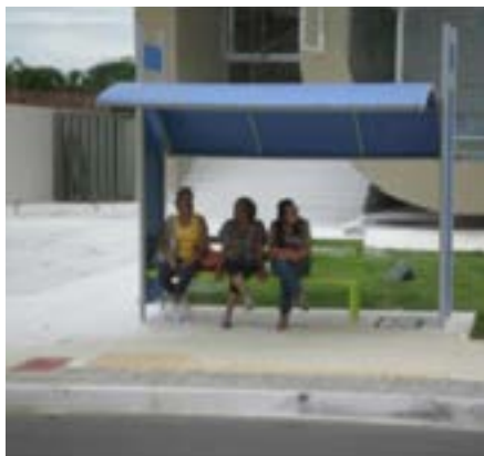
Além da reforma estética, pontos de ônibus foram refeitos para abrigar cadeirantes (Crédito: Pirâmide Engenharia)
