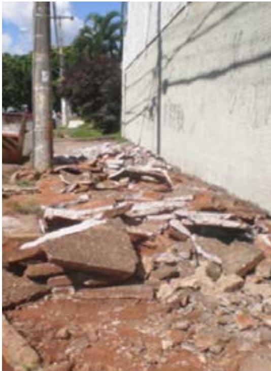
O entulho da remoção da calçada anterior (269,50 toneladas) foi utilizado na construção da nova calçada, representando mais de 2/3 do material necessário. A reutilização do entulho tornou-se uma premissa do projeto. (Crédito: Pirâmide Engenharia)
