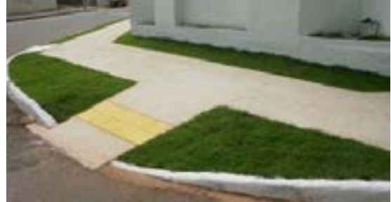
Depois da reforma das calçadas. (Crédito: Pirâmide Engenharia)
