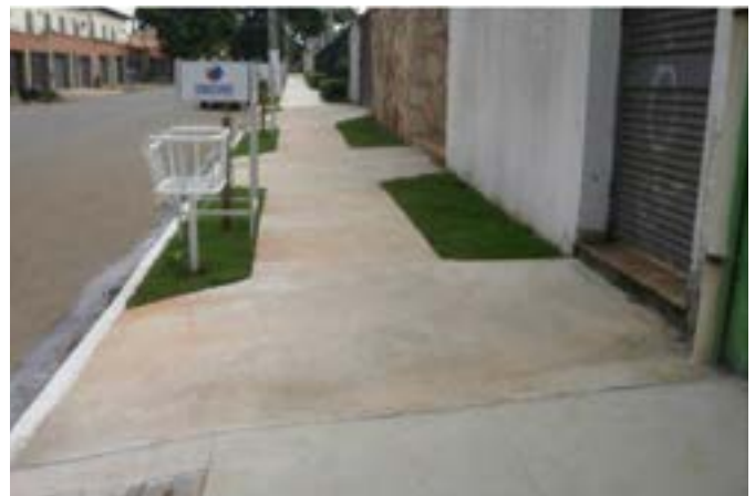
Calçada antes e depois da reforma, (Crédito: Pirâmide Engenharia)
