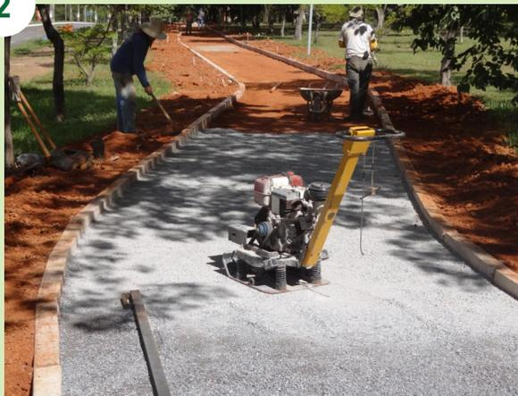
Após a distribuição dos grãos, a camada deve ser compactada, com placa ou rolo vibratório.
