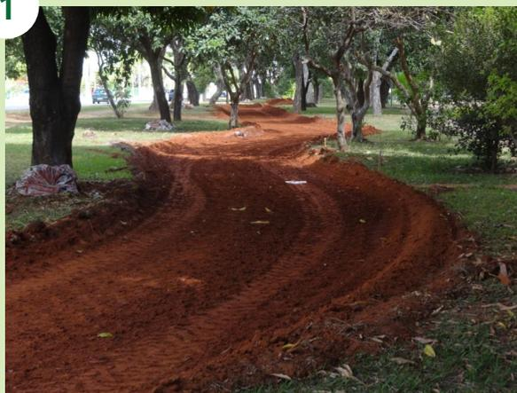
Abertura da caixa, com profundidade mínima de 20 cm e inclinação igual ao do pavimento acabado.
