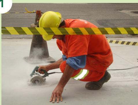
O Projeto Executivo de Engenharia deve prever juntas transversais de retração e de construção. Estas devem ser serradas com serra de disco diamantado, assim que o concreto aceitar o corte sem se danificar. A profundidade do corte deve ser especificada.
