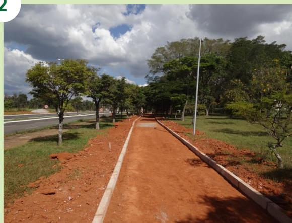
Colocação de guias premoldadas bem niveladas. Regularização e compactação do subleito.
