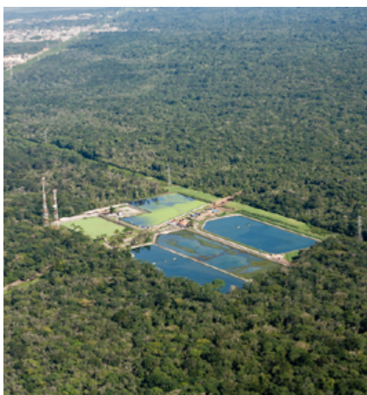
Vista aérea da ETE: destaque para as LFs nas laterais e LM ao centro. (Crédito: Reprodução site Riviera).
