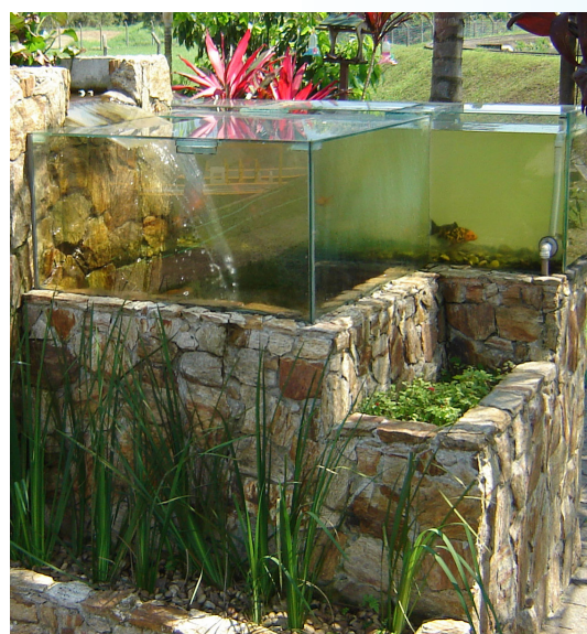
Ao final do processo de tratamento de esgoto, após a desinfecção da água, parte dela circula por um aquário que serve como teste de qualidade e funciona também para demonstrar a eficácia do sistema. (Créditos: Divulgação).
