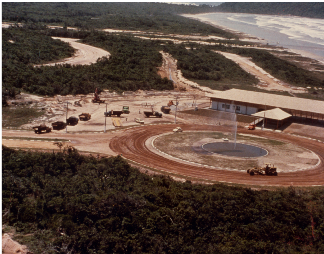
Quando o loteamento da Riviera de São Lourenço começou a ser implantado, a Estação de Tratamento de Água (ETA I) tinha capacidade de tratamento de 15m 3 /h. Por volta de 1988, ela foi substituída pela ETA II, com atuação pressurizada e capacidade de tratamento de 90m 3 /h. A ETA III, atualmente a única em funcionamento, opera com capacidade de 350m 3 /h, em sistema convencional. (Crédito: Divulgação).
