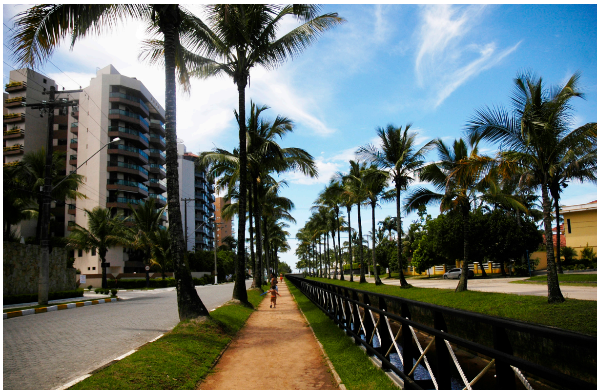
Canais de drenagem. (Crédito: ALB Marques).
