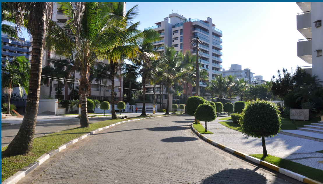
Pavimento intertravado com juntas drenantes instalado em 195mil m 2 de vias: escolha que permite maior permeabilidade e facilita a manutenção, além de melhorar a iluminação pública por ser mais claro.
