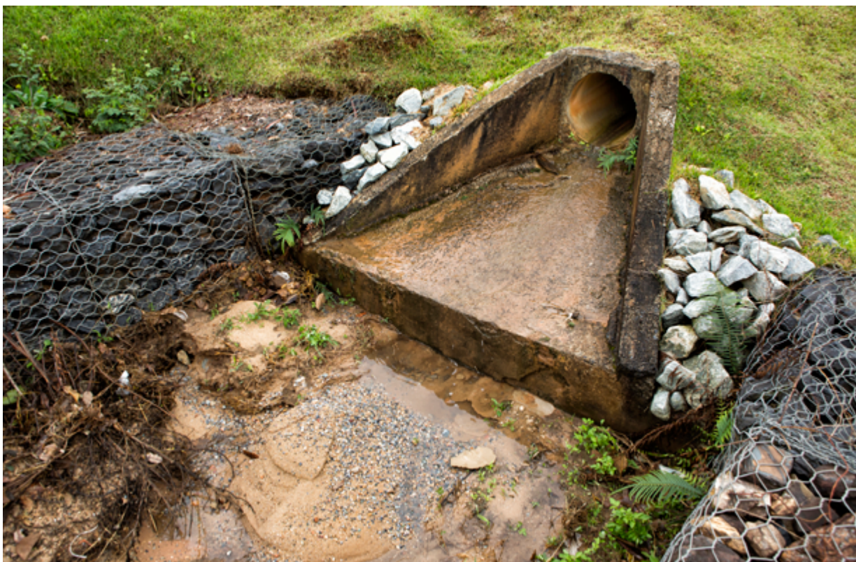
Vista de uma das bacias de retenção (1) implantadas e das canaletas impermeabilizadas (2) que conduzem água ao dique implantado ao fundo do terreno.
