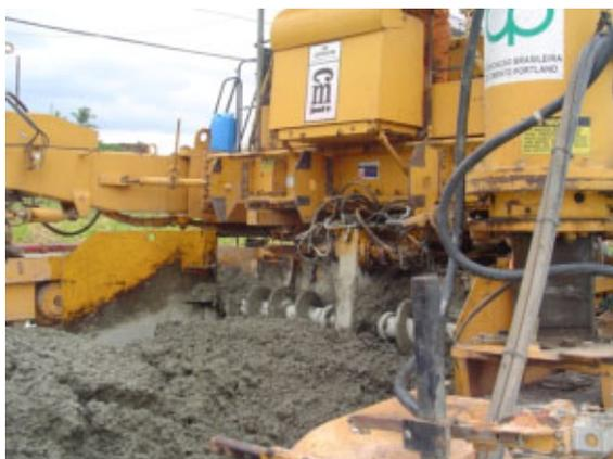
Figura 15 – Adensamento do concreto é feito com o auxílio de vibradores de imersão
