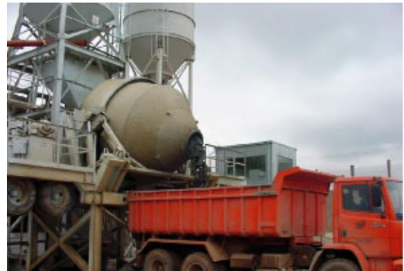
Figura 12 – Produção do concreto na obra (usina dosadora e misturadora)
