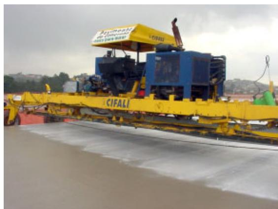
Figura 18 - Cura química mecanizada
