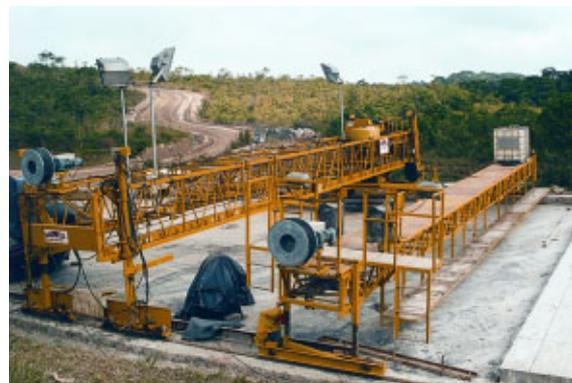
Figura 7 – BID-WELL - acabadora operando sobre fôrmas fixas
