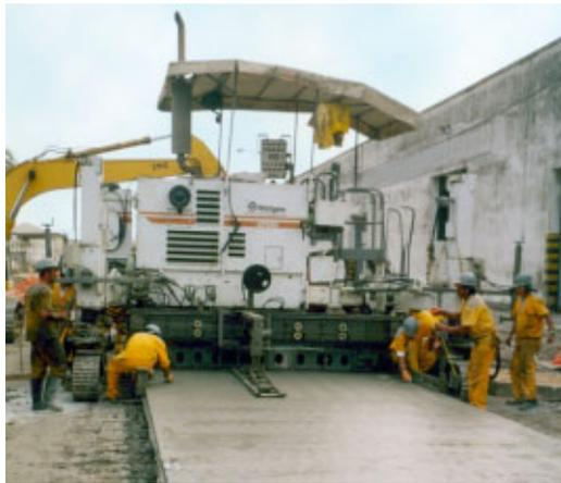
Figura 10 – Wirtgen SP 500 - vibroacabadora de fôrmas deslizantes
