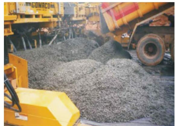
Figura 13 – Transporte e lançamento do concreto com caminhões basculantes
