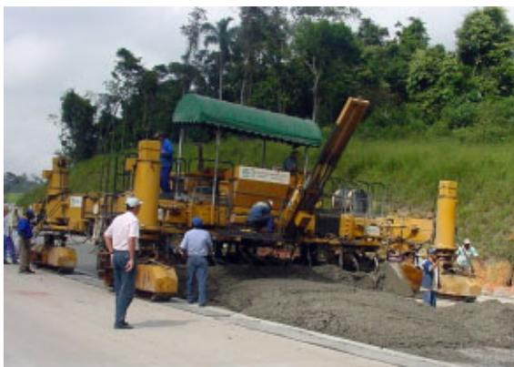
Figura 14 – Espalhamento do concreto executado pela rosca sem-fim da vibroacabadora
