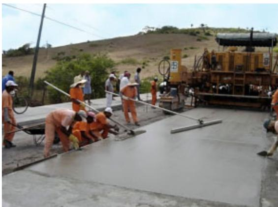
Figura 16 – Acabamento do concreto
