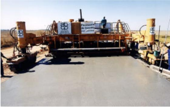
Figura 9 – CMI - 3004 F (4 esteiras) - vibroacabadora de fôrmas deslizantes
