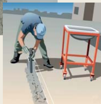
Figuras 5 e 5a Aplicação da argamassa
