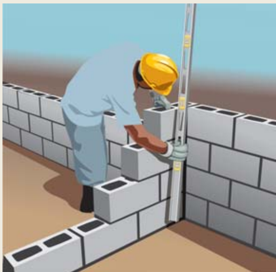
Figura 21 - Verificação do prumo e alinhamento da parede
