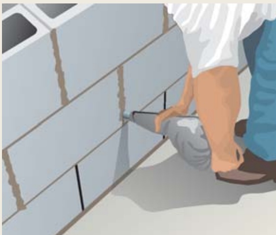
Figura 22 - Preenchimento das juntas verticais
