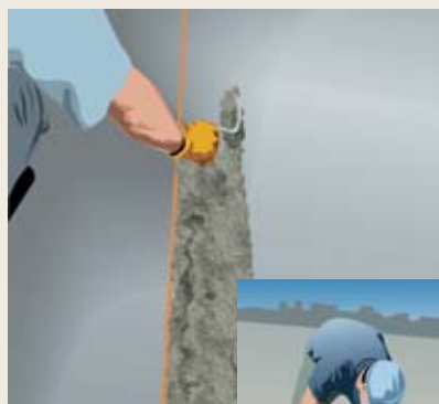
Figuras 5 e 5a Aplicação da argamassa
