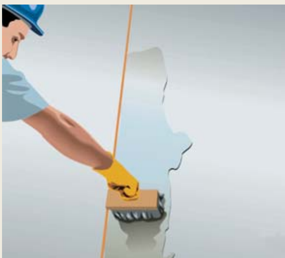
Figura 4 - Procedimento para molhar o pavimento
