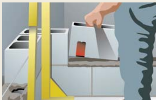
Figura 11 - Assentamento do bloco elétrico
