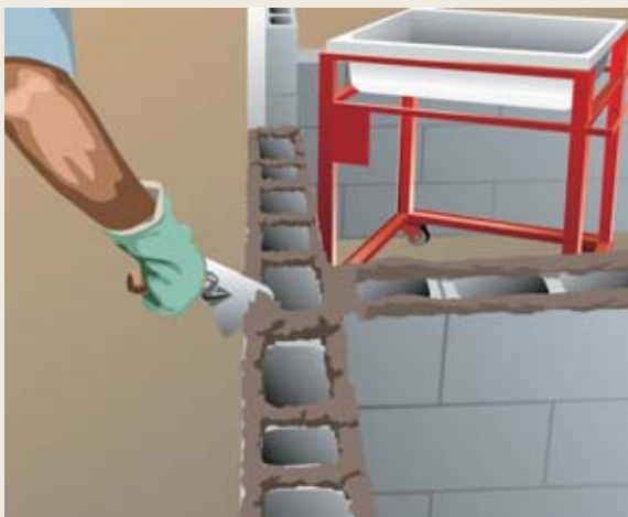
Figura 16 Aplicação da argamassa (Alternativa A)
