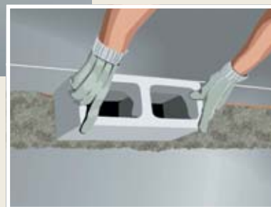
Figuras 6a Assentamento do bloco
