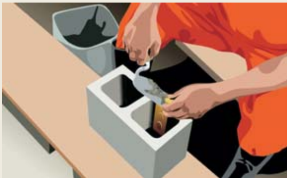
Fig. 1 - Aplicação das caixas elétricas nos blocos
