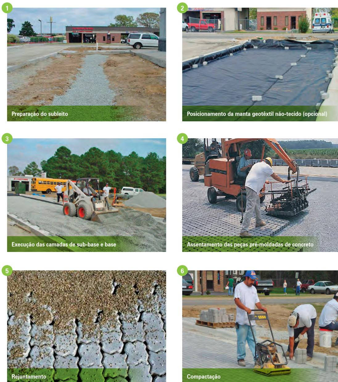
**Figura 12** - Etapas para a execução de um pavimento permeável com peças pré-moldadas de concreto
