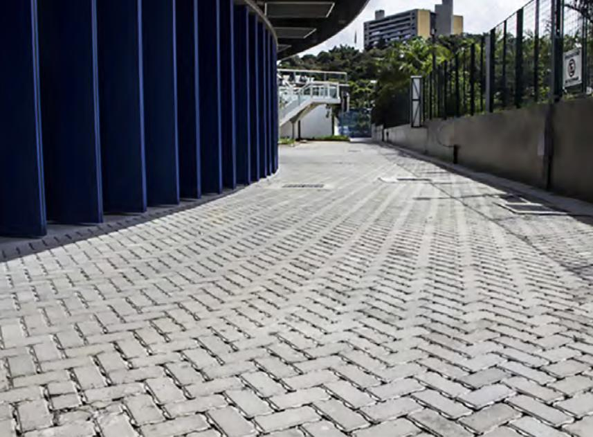
**Figura 2** - Pavimento intertravado permeável
