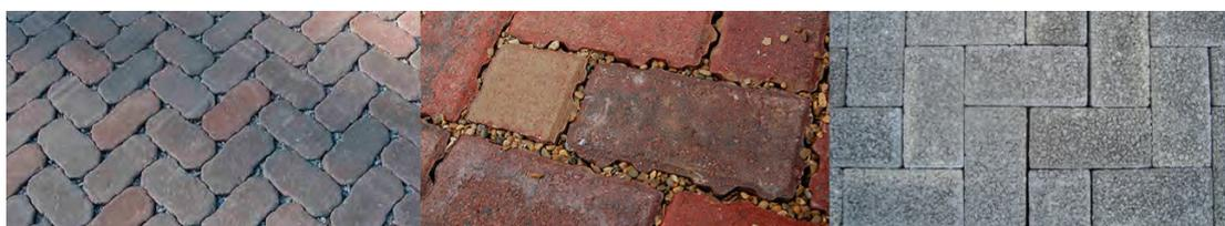
**Figura 9** - Camada de revestimento do pavimento permeável intertravado: peças de concreto com aberturas específicas para infiltração de água (esquerda), com infiltração pelas juntas de assentamento (centro) e com peças de concreto poroso (direita).
