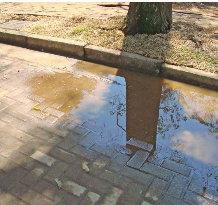
**Figura 14** - Pavimento permeável com colmatagem das juntas devido ao acúmulo de sedimentos
