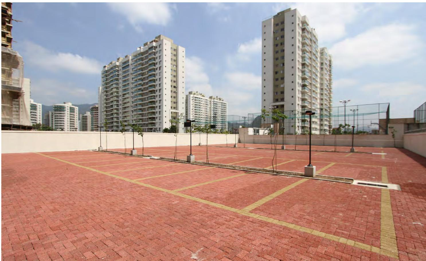
**Figura 7 - Pátio de condomínio com pavimento intertravado permeável**
