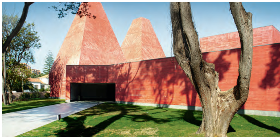
Com duas torres adjacentes, em forma de pirâmide, a “Casa das Histórias Paula Rego” é um destaque na paisagem.
