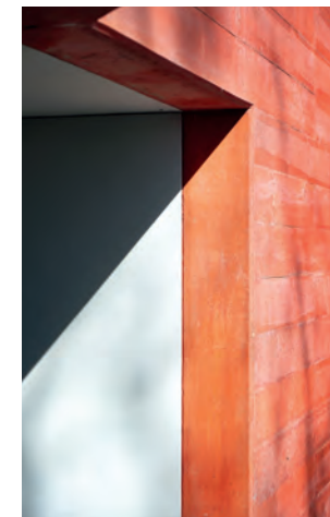
As paredes interiores com reboco branco formam um contraste evidente com o concreto colorido em vermelho.
