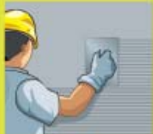
Em base de concreto use chapisco denteado.
